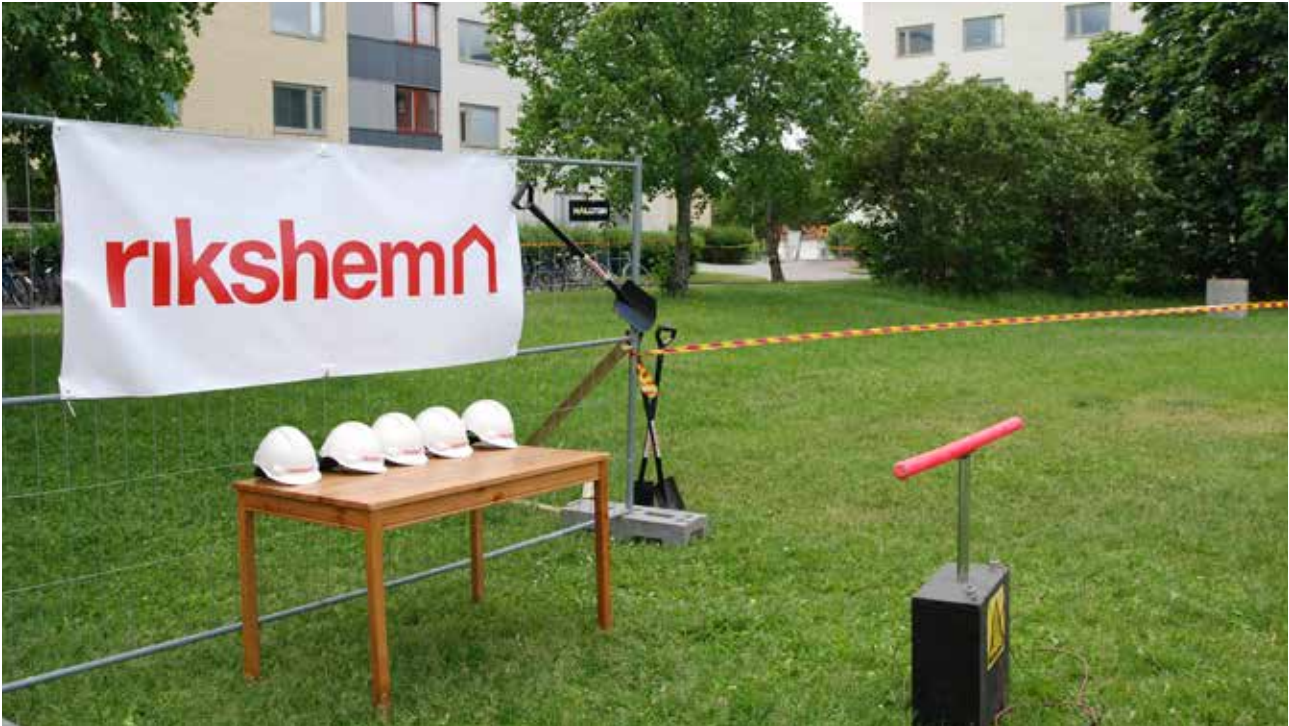
Den 18 juni var det byggstart för 366 hyres- och studentlägenheter i området Kantorn i Uppsala.
