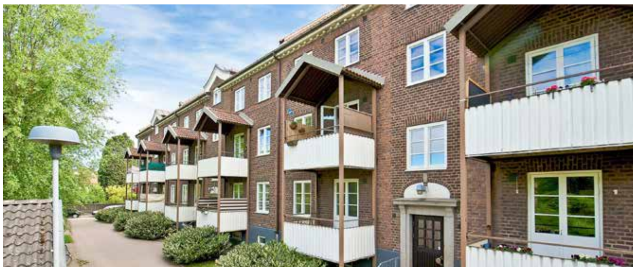
Fastigheten Maria 1, Helsingborg
